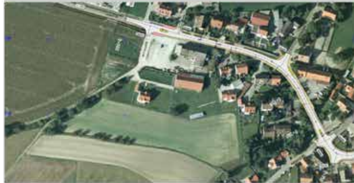
Ausbau 2. Bauabschnitt Ortsdurchfahrt Wiedenzhausen Errichtung fehlender Gehwege
